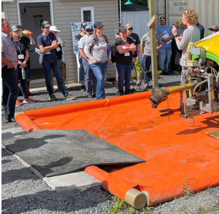
Aire souple de lavage et remplissage
